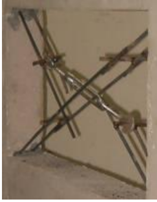
Şekil 11 Çapraz filizlerinin gerdirilmesi
