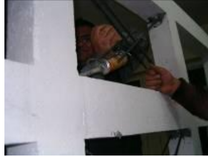
Şekil 8 Epoksi enjeksiyonu
