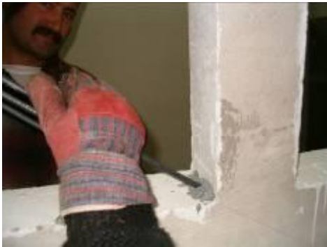
Şekil 9 Çapraz filizlerinin yerleştirilmesi
