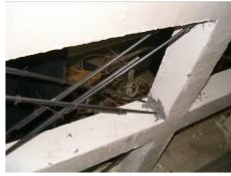
Şekil 10 Çapraz filizlerinin sabitlenmesi
