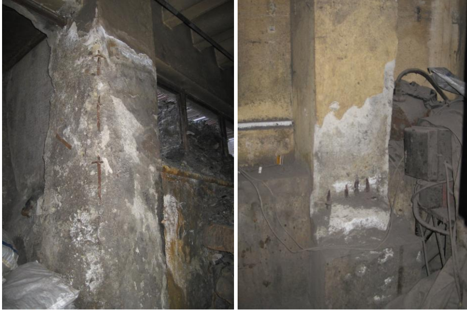
Şekil 2.7 AKML bodrum kat kolon ve donatı görüntüsü
