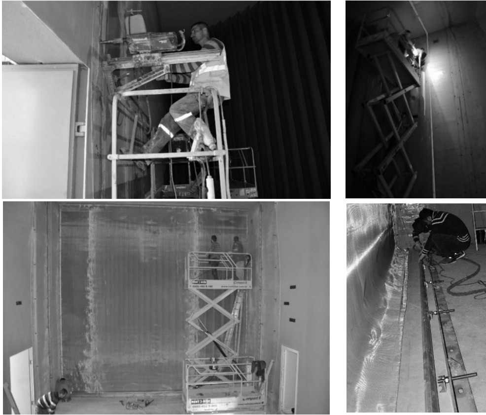
Şekil 6. Perdelerin tünel içerisine bütünlenme süreci.
