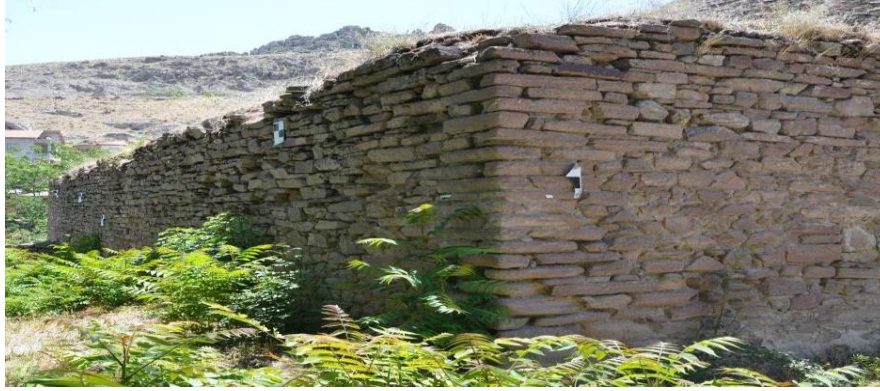
Şekil 7. Hamamın doğu cephe görünüşü
