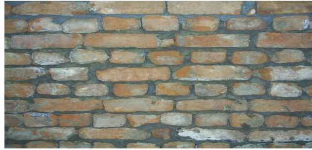
Şekil 1. Örülmüş tuğla duvarın görüntüsü
