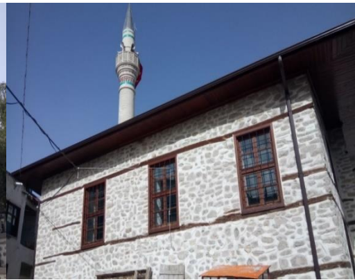
Şekil 5. Caminin batı cephesi
