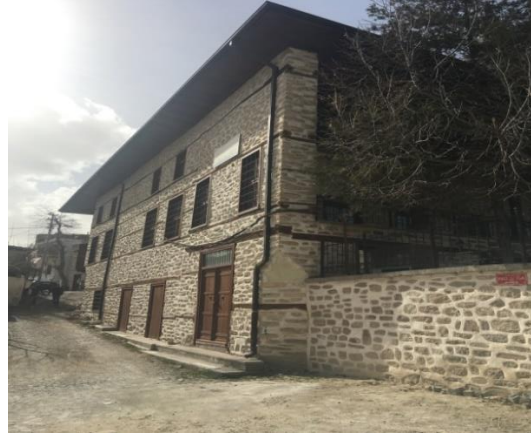
Şekil 7. Caminin güney cephesi
