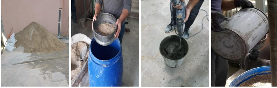
Şekil 4. Kumun varile yerleştirilmesi ve enjeksiyon harcının hazırlanıp enjeksiyon tankına yerleştirilmesi
