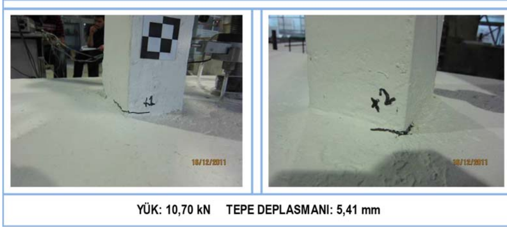
Şekil 8. RF numunesinde ilk oluşan çatlaklar [17]
