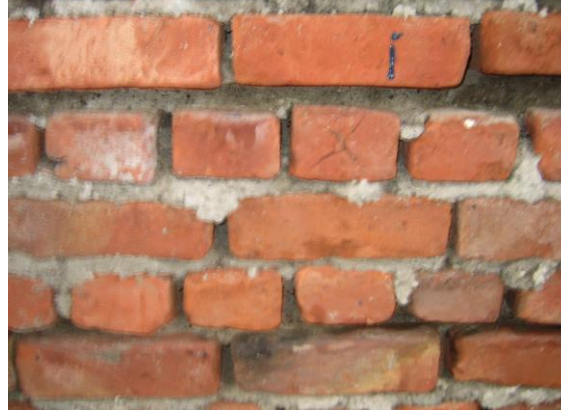
Şekil 17 Örülmüş tuğla duvarın görüntüsü
