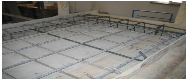
Şekil 16 Döşeme donatısının görüntüsü
