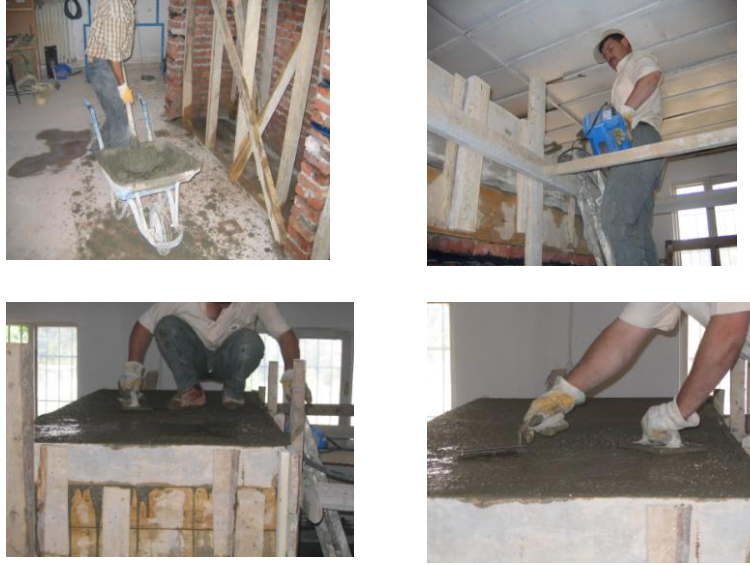
Şekil 19 Numuneye kalıp kurulması ve beton dökülmesi
