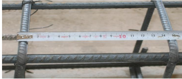
Şekil 15 Bağ kirişi donatı görüntüsü
