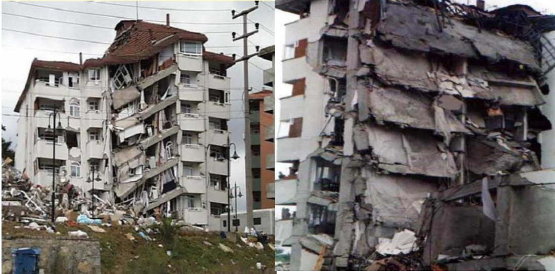
Şekil 2. Döşeme süreksizliği nedeniyle hasar görmüş yapılar [1]
