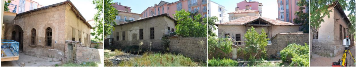
Şekil 2. Yapı çevresi ve cepheleri
