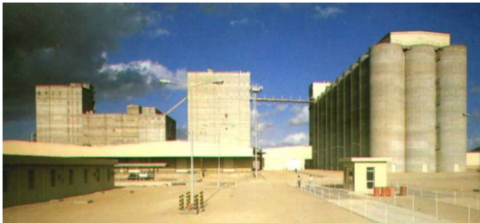
Şekil 6. Un Fabrikasına ait Kuru Buğday Siloları ve Tav Siloları (4).
