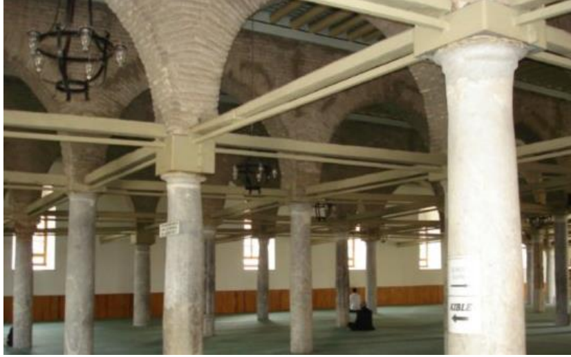
Şekil 1. Konya Alaaddin Camii sütun atkılarında yapılan restorasyon çalışması.
