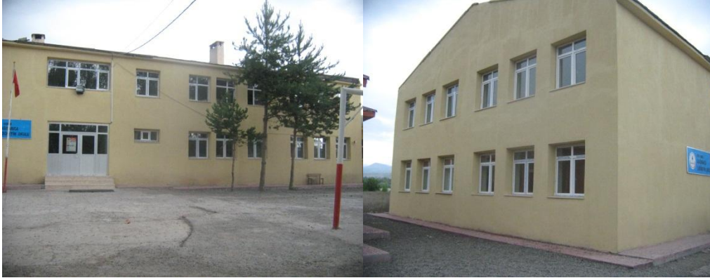
Şekil 1. Aşağısarıca İlköğretim Okulu
