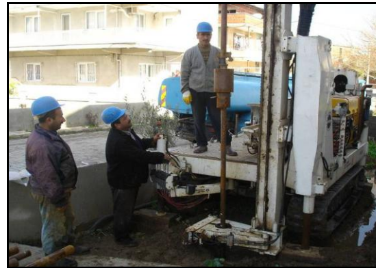
Şekil 3. Çalışma alanında SPT sondaj çalışması
