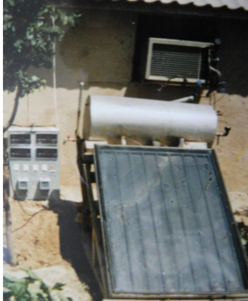
Şekil 1.b. Çift fazlı güneş enerjisi kaynaklı ısı pompası sistemi deney tesisatının fotoğrafı (kollektör eğim açısı 45°)
